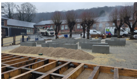
Avancée des travaux, janvier 2025
