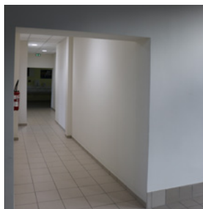
Couloir terminé, février 2025
