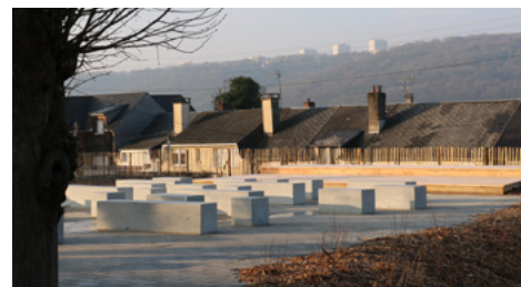
Avancée des travaux, février 2025
