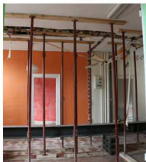
Couloir en travaux, septembre 2024
