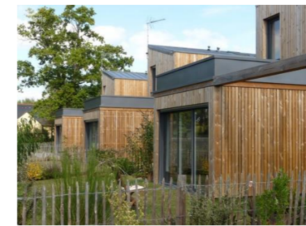
Clôtures composées d'une ganivelle et de petits végétaux préservant la perception d'un vaste espace vert. Ecoquartier du Clos des Moulins, La Chapelle-des-Marais (44)
