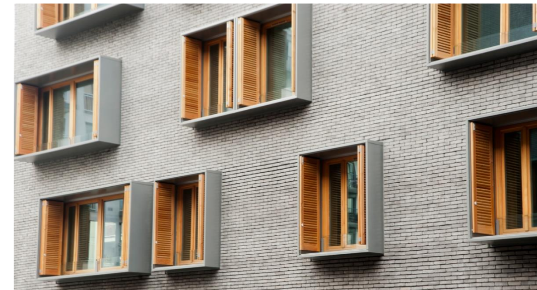
Exemple d'un traitement sobre des étages courants avec une façade revêtus de brique et des encadrement de fenêtres valorisés.
