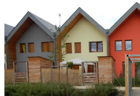
Avancée du toit permettant une protection solaire et de la pluie. Intégration des abris de jardin à la clôture. ZAC des Noës, Val de Reuil.
