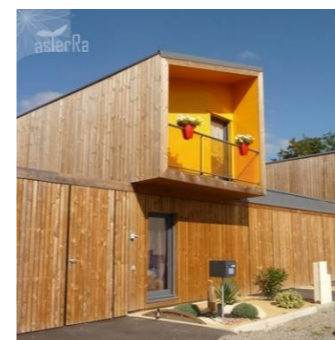
Traitement de certaines parties en porte-à-faux, exemple dans l'écoquartier du Clos des Moulins à La-Chapelle-des-Marais (44)
