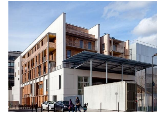
La façade prend de l'épaisseur : elle intègre des balcons et des coursives, et une seconde peau constituée d'une structure métallique, des volets en bois, de bardages en bois et en éternit qui contribue à la basse consommation énergétique des logements. Le bâtiment est à basse consommation ; Paris
