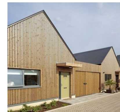
Exemple de maisons en bande avec les garages regroupés entre deux logements. Un auvent ainsi qu'un matériau spécifique au sol marquent l'entrée. Londres
