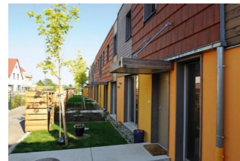
Exemple d'un aménagement intégrant un cheminement menant à la maison, une partie engazonnée, un ensemble enveloppé de bois pour les éléments techniques (compteurs, collecte des déchets). Ribeauvillé
