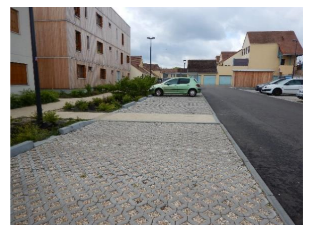
Stationnement en poche semi imperméabilisé. ZAC des Noës ; Val de Reuil
