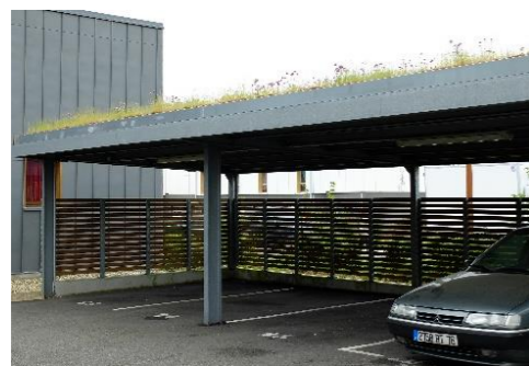
Poche de stationnement couverte avec une toiture végétalisée (5 ème façade perçue depuis les étages du bâtiment). Gonfreville-L'Orcher
