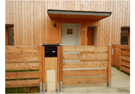
Eléments techniques intégrés à la clôture des logements. ZAC des Noës à Val de Reuil
