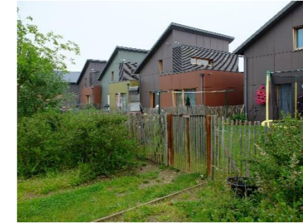
Traitement végétal doublée d'une ganivelle, de la limite entre l'espace public et l'espace privé. Portillon permettant d'accès à l'espace vert collectif depuis le jardin. Seineville-sur-Seine
