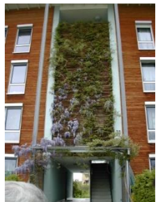
La façade prend de l'épaisseur : elle intègre des balcons et des coursives, et une seconde peau constituée d'une structure métallique, des volets en bois, de bardages en bois et en éternit qui contribue à la basse consommation énergétique des logements. Le bâtiment est à basse consommation ; Paris
