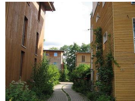
La végétation sera intégrée dès que possible au pied des immeubles. Quartier Vauban à Fribourg (Allemagne).
