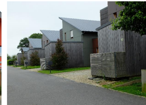
Intégration des éléments techniques dans le traitement des volumes. Seineville-sur-Seine.
