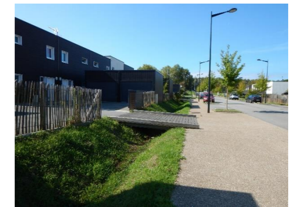
Desserte des logements par des ponts au-dessus des noues. Ecoquartier du Grand Hameau, Le Havre
