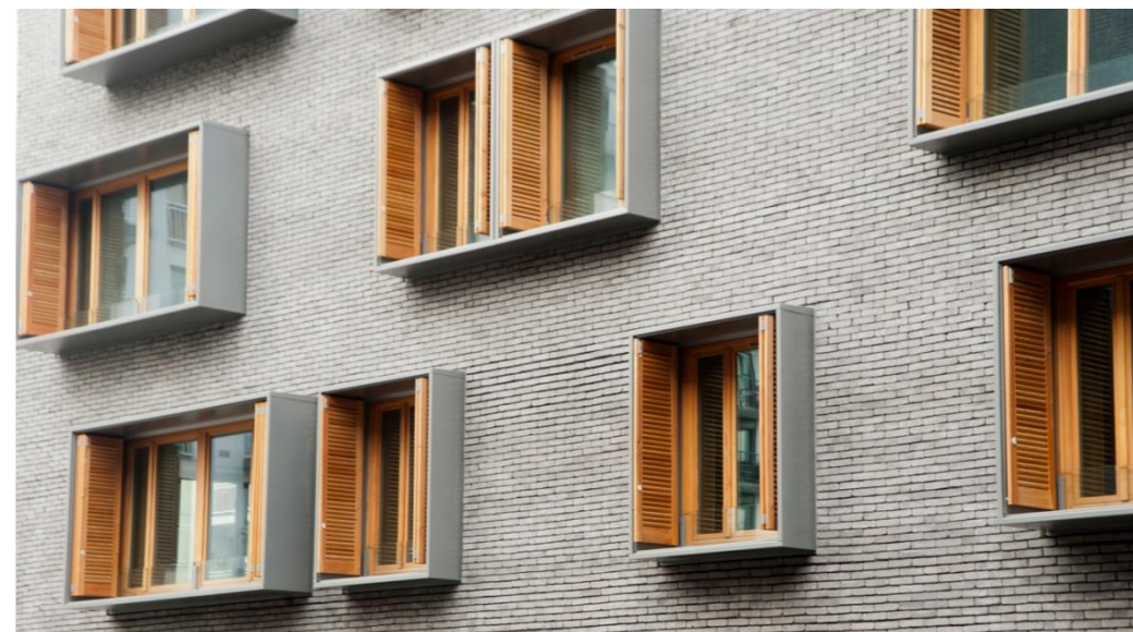
Exemple d'un traitement sobre des étages courants avec une façade revêtue de brique et des encadrements de fenêtres valorisés.
