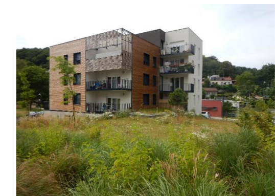
Exemple de façades structurée par un jeu sur les matériaux et intégrant des balcons. Opération « les pins au balcon » à Elbeuf.
