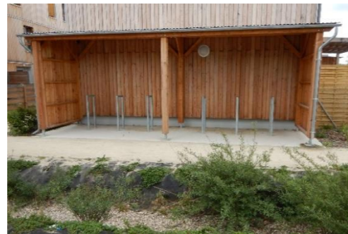
Abri pour vélo collectif. ZAC des Noës ; Val de Reuil
