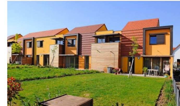
Terrasse des espaces extérieurs situées en prolongement du salon et couvertes par une intégration d'une pergola à la façade du bâti. Eclairage de l'espace extérieur intégré à la façade.
