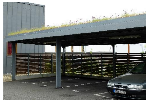
Poche de stationnement couverte avec une toiture végétalisée (5 ème façade perçue depuis les étages du bâtiment) ; Gonfreville-L'Orcher
