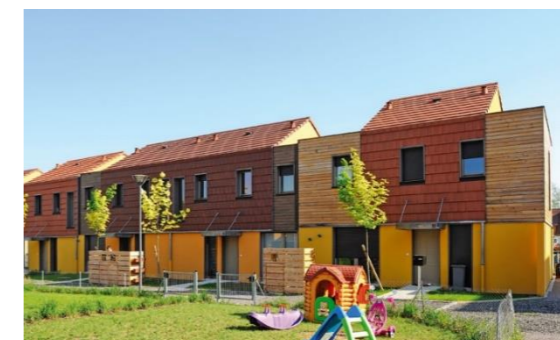
Les structures des murs sont en briques de terre cuite isolante et les niveaux supérieurs en ossature bois. Ces deux systèmes constructifs ont l'avantage d'éviter les ponts thermiques, ce qui permet d'atteindre un très bon niveau de confort et de performance énergétique et se reflètent en façade avec une mixité de matériaux. Ribeauvillé
