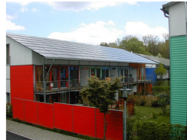
Exemple d'immeuble collectif une toiture mono-pente couverte de panneaux solaires. Des balcons sont prévus pour les logements situés à l'étage et des jardinets sont offerts aux logements situés en rez-de-chaussée.
