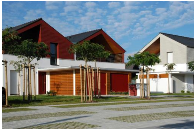
Stationnement en box individuels, traités devant les logements.
