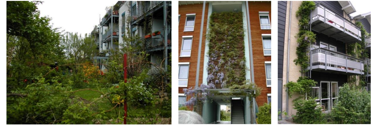
Un exemple à Irmsher (Allemagne) à Copenhague (Danemark) où la structure métallique des balcons crée des supports pour les plantes grimpantes.
