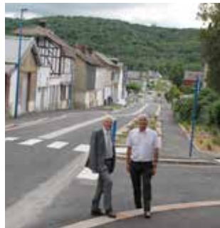
réception des travaux de la rue Duflou
